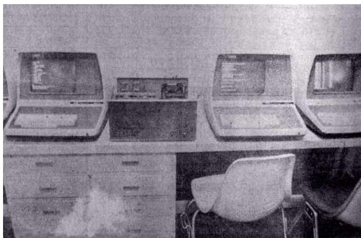
Prototipo del Concentrador Inteligente de Terminales y pruebas oficiales de su funcionamiento
